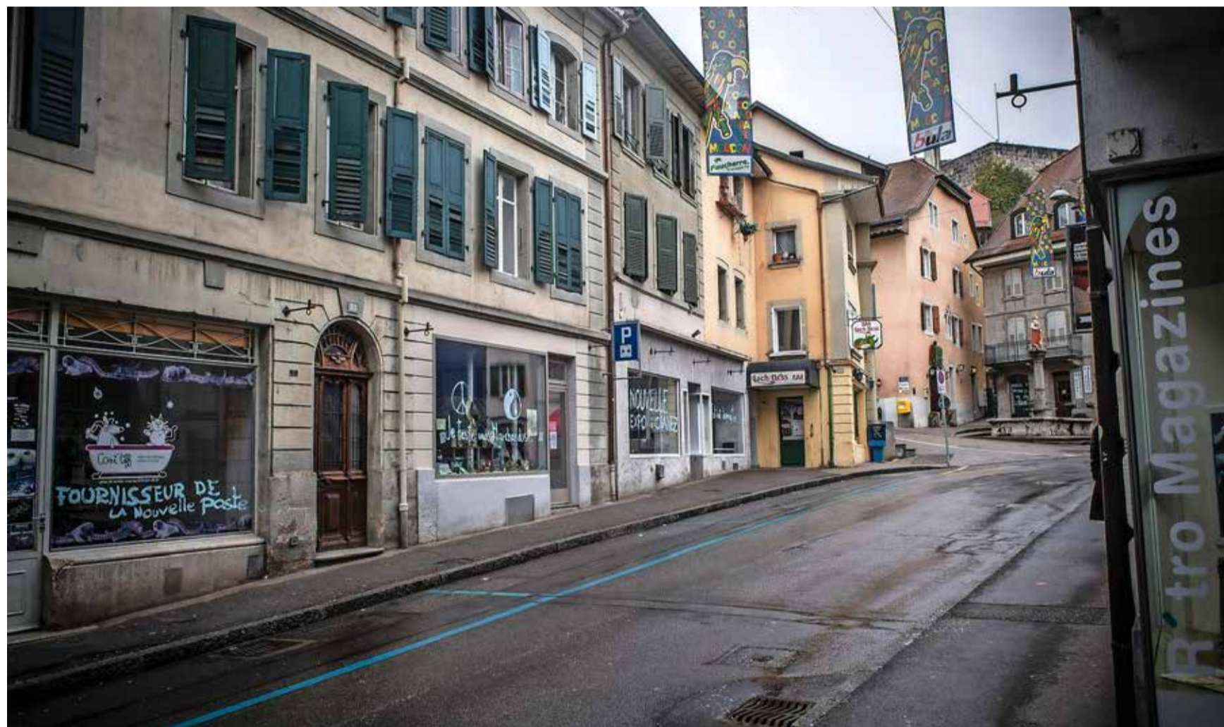
Le prévenu détient deux immeubles situés à la Grand-Rue à Moudon. Même si le permis d'habiter lui a été retiré en 2005, il loge toujours une trentaine de personnes. Alain Wicht
